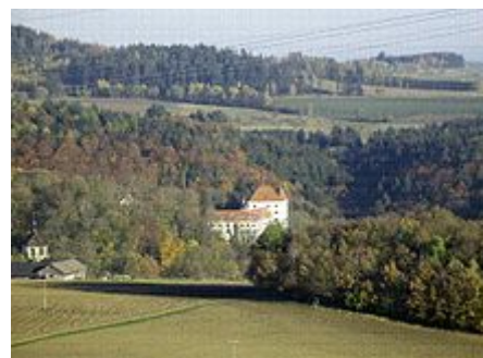
Die Burg Guttenberg liegt auf einem bewaldeten Bergsporn, der nur von der Ortsseite einfach zu erreichen ist.
