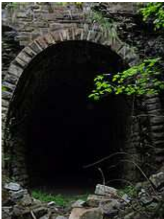
Nordportal des Kesselbergtunnels 2009
